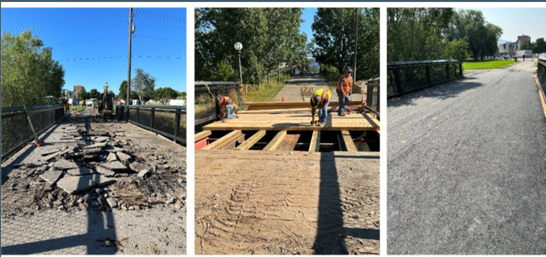
Van Buren Street Footbridge
